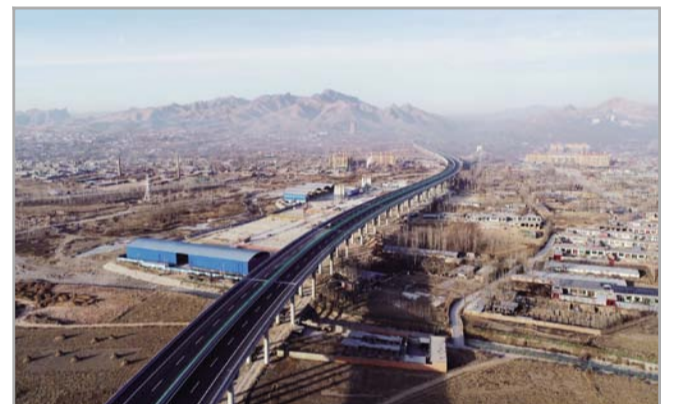
▲2018年12月28日，局承建太行山高速项目建成通车。该高速全长约652公里，是河北省投资最大的高速公路项目和《京津冀协同发展交通一体化规划》重点工程，由北向南贯穿太行山区全境。图为投资公司承建津曲段38公里路面摊铺。
