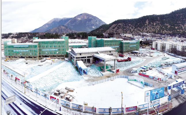
▲近日，西南分公司林芝宾馆改扩建EPC项目完成主体结构施工。该项目是我局与三峡集团合作的首个在藏项目，总建筑面积2.5万平方米，建成后将承担林芝市对外展示和对外接待的重要功能。陈利华 张洪爽 / 摄
