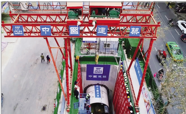
▲2018年12月27日，一公司西安综合管廊202项目雁南一路管线管廊G类节点井-H类节点井段顶管机顺利始发，标志着目前国内管廊施工中直径最大的顶管进入施工阶段。刘博元 / 摄
