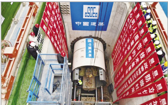
▲近日，一公司西安市地下综合管廊PPP项目I标段雁南一路缆线管廊项目G类节点井-H类井段贯通。该段管廊全长1.1千米，为顶管施工，建成后将直接为陕西大剧院供电。 刘博元 / 摄
