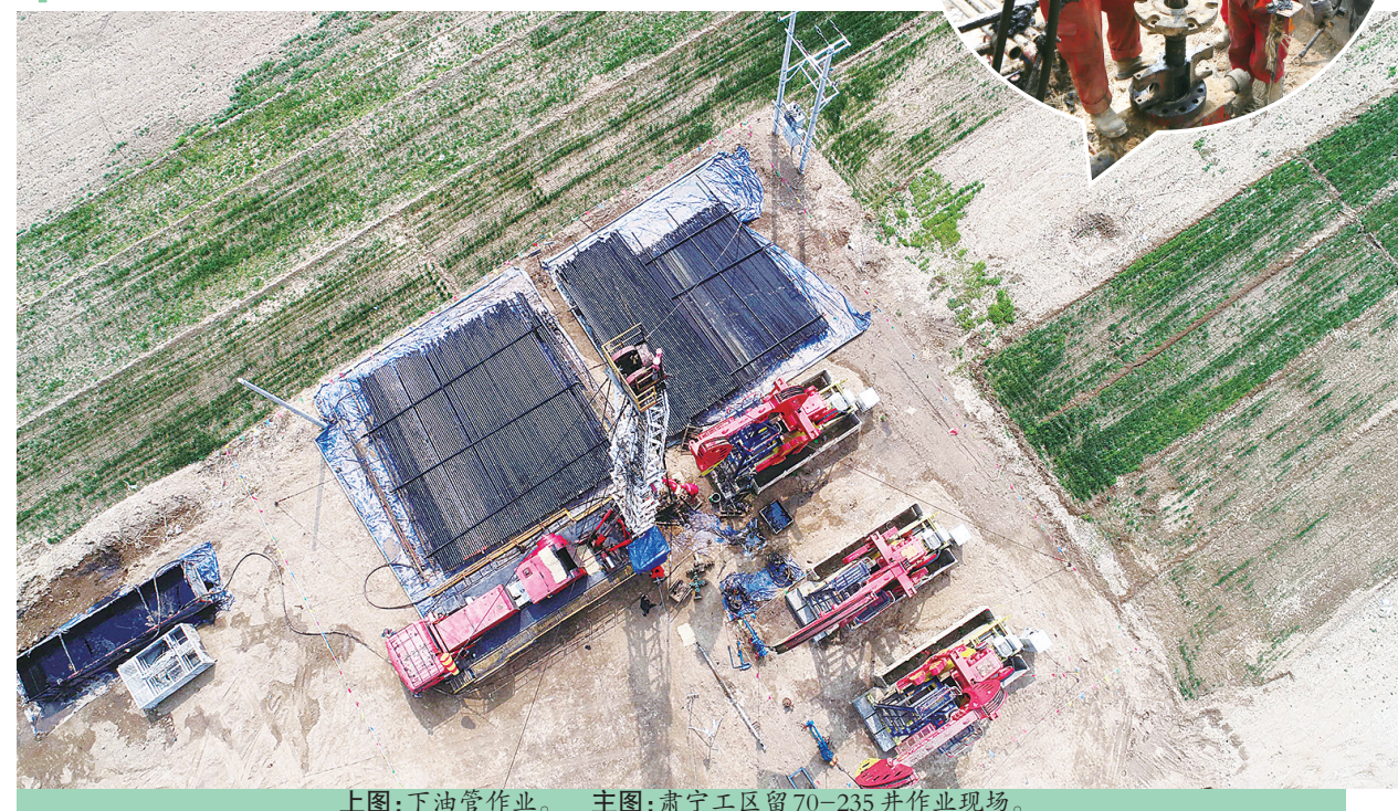
上图:下油管作业。主图:肃宁工区留70-235井作业现场。
