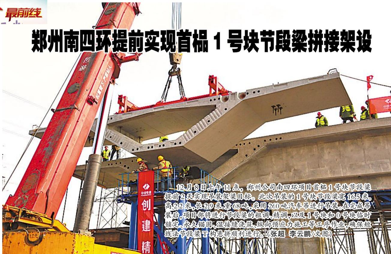
12月8日上午11点，郑州公司南四环项目首榀1号块节段梁提前2天实现吊装架梁目标。此次吊装的1号块节段梁宽16.5米，高2.2米，长2.9米，重68吨，采用260吨汽车吊进行吊装。在完成吊装后，项目部将进行节段梁的粗调、精调，以及1号块和0号块临时锁定、永欠锚固、湿接缝浇筑、纵向预应力施工等工序作业，确保短线法节段梁T构悬拼顺利进行。（张超 李云鹏/文图）
