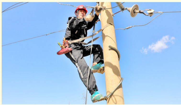
电讯队高压组组长郭俊杰进行检修作业。
