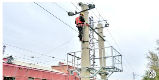
图⑨ 矿山铁路分公司员工参加供电外线电工更换绝缘子工种比武。
