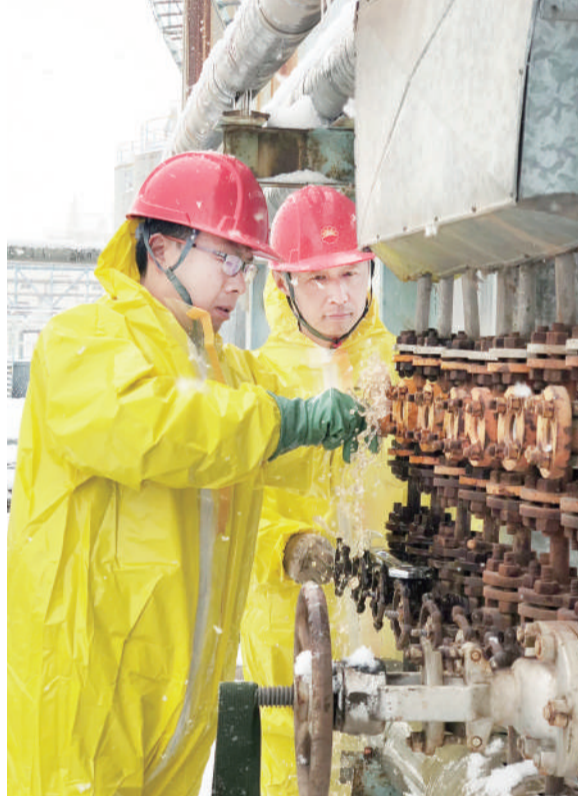
化肥厂丙烯酸车间岗位员工冒雪作业,及时消除漏点,保证装置安全稳定生产。(刘佳)
