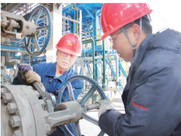
聚丙烯厂员工对装置内的阀门进行检查,杜绝“跑冒滴漏”,确保环保受控。(李发龙)
