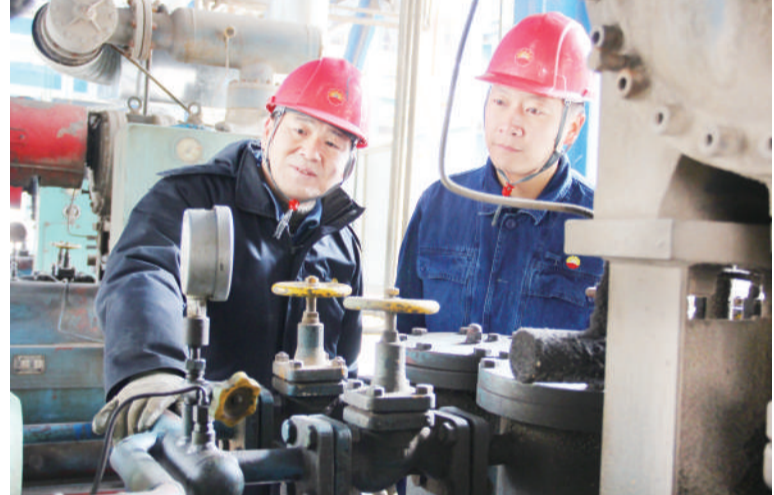
炼油厂连续重整车间员工对机泵进行巡检。(李发龙)
