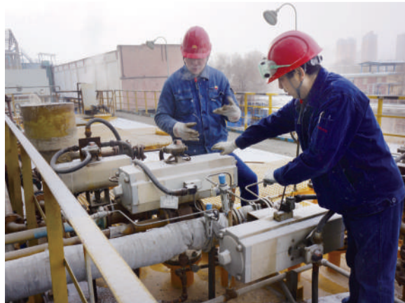
在各装置管理人员的带领下,催化剂厂加强巡检,对易冻堵部位增加防护措施。(代忠海)
