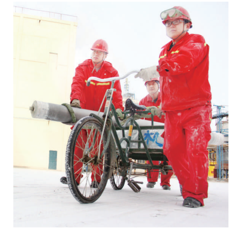
设备维修公司员工及时将检修拆卸下的设备运回,进行处置。(李发龙)
