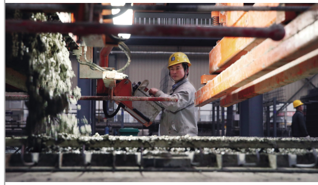
▲近日，中建机械自主设计研发的智能布料系统成功应用于PC预制构件生产线。该系统设计有称量装置、安全装置，整个系统与BIM对接，提高了整线的自动化、信息化水平。刘爽/摄
