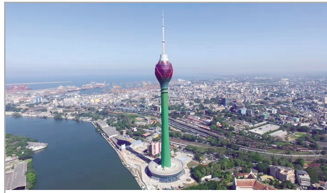
▲近日，安装公司斯里兰卡莲花电视塔机电和钢结构工程竣工，目前正在验收调试阶段。该工程是斯里兰卡首都的代表性地标建筑，也是南亚第一高塔。李峰 李萍/摄
