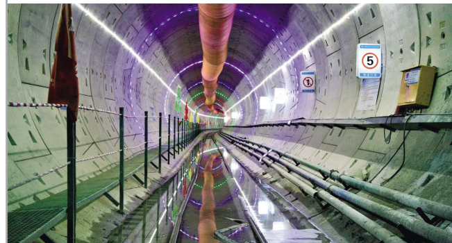
▲4月25日，郑州轨道3号线难度最大的盾构区间（二七广场站-顺城街站）贯通，该工程由北京分公司承建，这标志着局在地铁施工技术领域又一次取得重大突破。李高 张帆/摄
