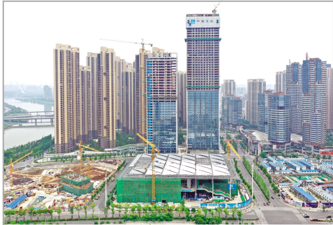
▲近日，一公司北辰A3项目封顶。该项目位于长沙市北辰新河三角洲的商务中心区，总建筑面积约20万平方米，由一栋4层国际会议中心，一栋40层酒店、一栋59层办公楼组成。
