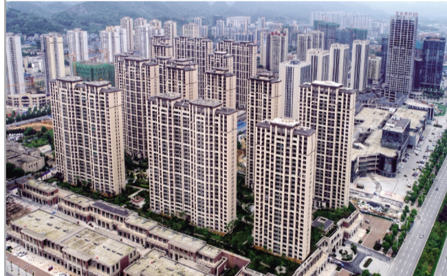
▲近日,三公司遵义实地蔷薇国际项目竣工。该项目位于遵义市新蒲新区,总建筑面积32万平方米,包含15栋高层住宅及3万平方米的商业临街。
