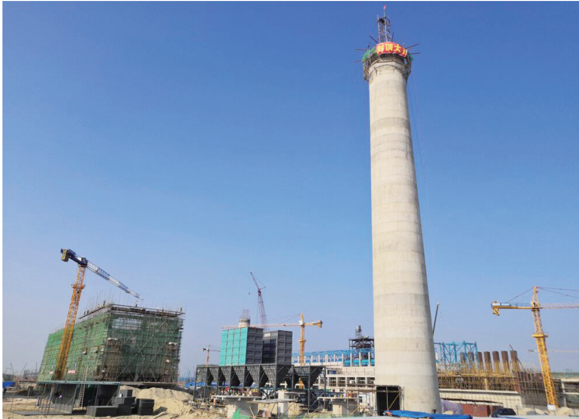
防城港钢铁基地2x500m 2 烧结项目成品除尘烟囱顺利封顶。该烟囱外筒为钢筋混凝土结构,顶标高为50米,±0.00米处筒壁外半径为3.47米,顶部出口外半径为2.47米,于7月31日开工建设。
