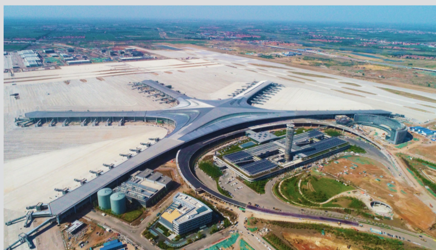
近日,由中建八局承建的青岛新机场项目已实现全面复工。项目预计于2020年交付使用,目前大部分工作已进入收尾和质量提升阶段。(冯浩、马强)
