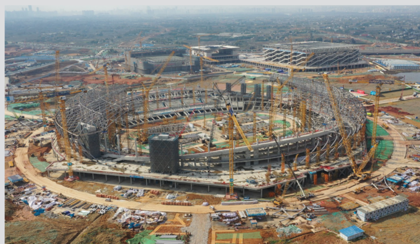
近日,中建二局安装公司参建的东湖体育公园项目复工。该项目打出防疫复工“组合拳”,为稳步推进施工生产提供了有力保障。(徐菁)
