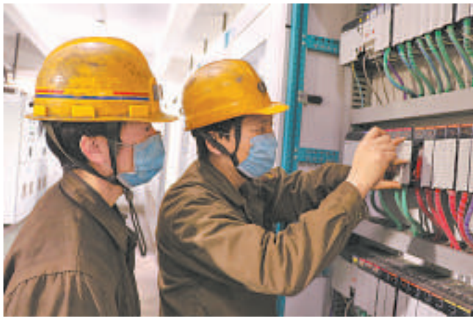
耿村煤矿紧绷安全生产弦,开展全面彻底的安全隐患排查,坚决筑牢安全风险防护网。图为3月22日,检修车间电修工在巡查高压配电室PLC机柜运转情况。
