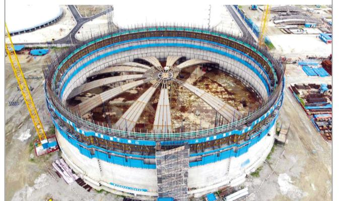
▲近日,中建电力江苏LNG储罐项目扩建工程20万立方米特大容量低温混凝土储罐墙体施工完成,进入穹顶土建设工阶段。白瑞雨/摄
