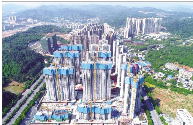
▲近日,三公司建设的湖南省郴州市首个装配式住宅工程——郴州美的云熙府项目一期一标全面封顶。任舒 / 摄
