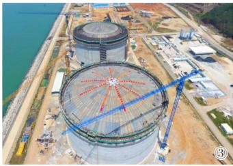
③4月29日，中建电力漳州LNG储罐土建工程2号储罐关键节点——顶升施工顺利完成。（王生亮、吴树勤）
