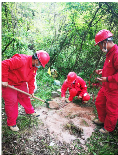
为保证施工质量,员工下药确保埋实。
