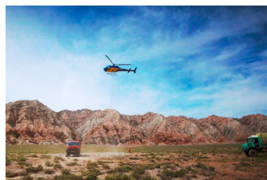
直升机进行吊装作业
