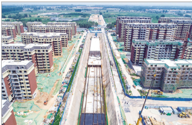
▲6月30日,二公司郑州中心城区地下综合管廊工程主体结构顺利完工。该项目是国家重点工程、郑州市首批地下综合管廊试点项目。 荣文昊/摄
