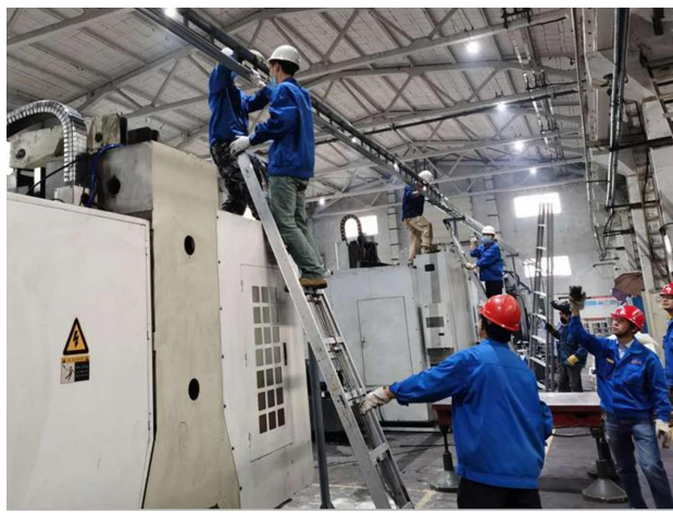
动力一厂维修人员正在对汉德车桥桥四厂 AB 线进行电源改造和桥架安装
