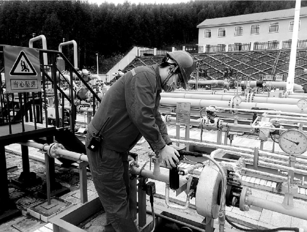
新型冠状病毒肺炎疫情期间,航测遥感局地理信息分公司系统集成分部天津、广西项目 SCADA 系统(数据采集与监视控制系统)维护组八名员工仍坚守岗位,通过对控制中心、场站、网关 SCADA 系统日常巡检,处理数据传输故障,保障天津、广西天然气管道有限责任公司 SCADA 系统平稳运行,安全生产。 南贝摄影报道
