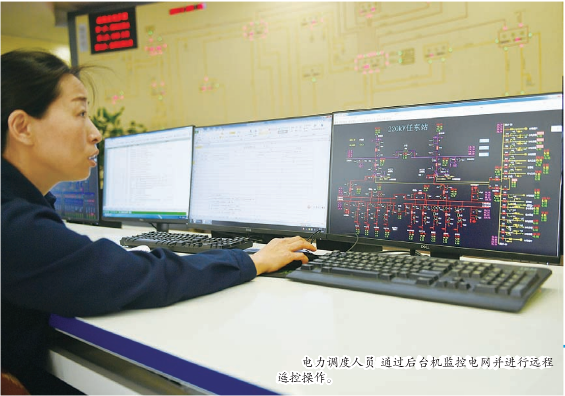
实施供电线路安全隐患治理,供电系统抗风险能力大幅提升,电网智能化水平进一步提升。
