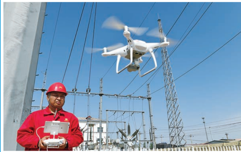
外线技术人员 升起无人机,准备巡线。
